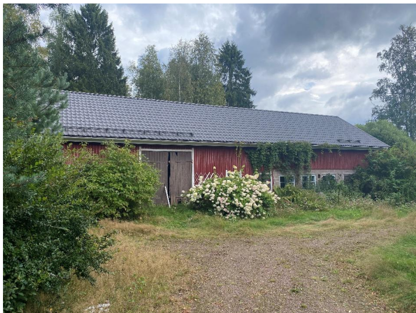
Kuva suunnittelualueen pohjoisosan talouskeskuksen talousrakennuksesta, joka on purettu kaavaprosessin aikana
