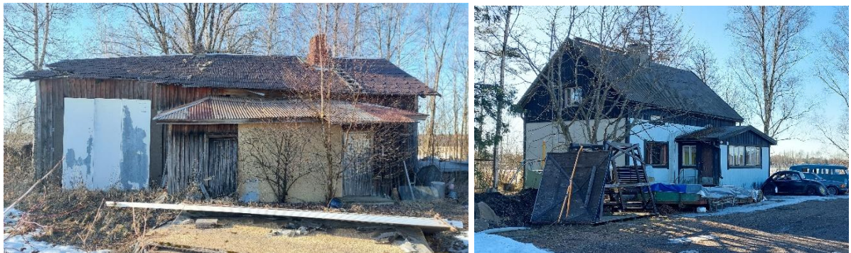
Kuva 3-22. Vasemmalla Peltöhyötiläntie 39 ja oikealla Peltöhyötiläntie 64. (Harjavan kaupunki maaliskuu 2023)
