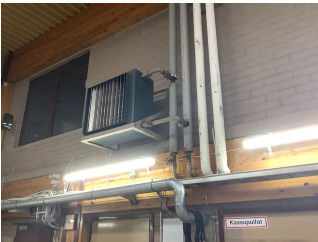
Autohalli 112. Tilan lisälämmityslaite, kiertoilmakojie.
