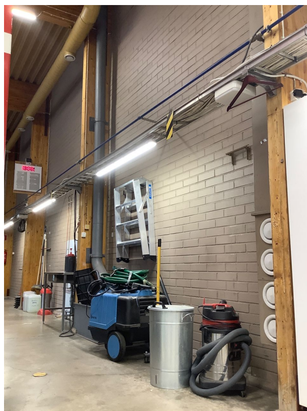
Autohalli 112. Poistoilmakanavisto.
