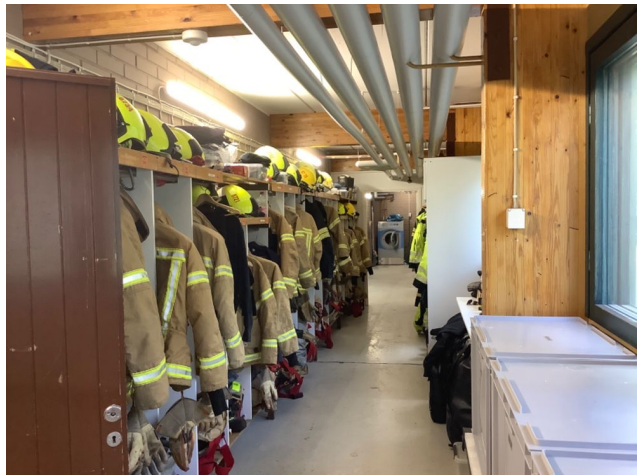
Tila 127. Entinen letkupesutila. Tilaan on rakennettu varustesäilytys. Ei ilmanvaihtoa.
