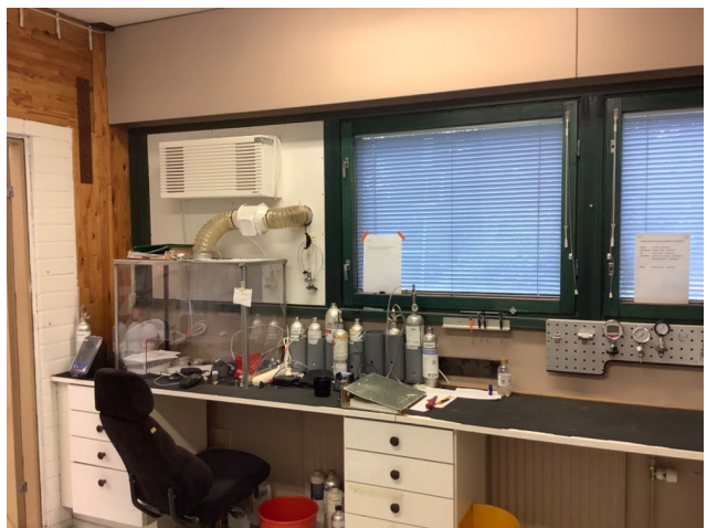
Tila 104. Tilaan tulee korvausilma Mobair -laitteen kautta.
