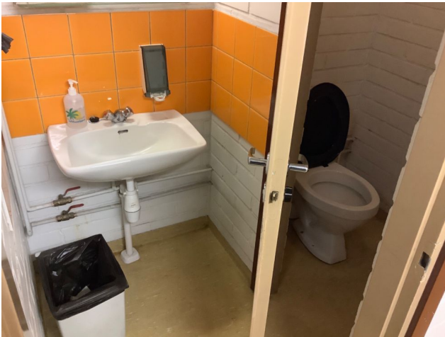
WC-tiloissa on alkuperäiset vesikalusteet. Kalusteet ovat toimivia.
