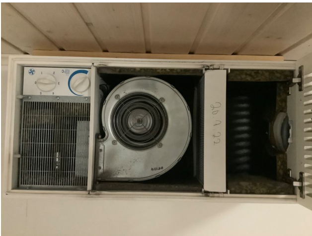
Puhukuone 134. Laitteen lämmitystermostaatin asento on täysillä, puhallusnopeus 3/5.
