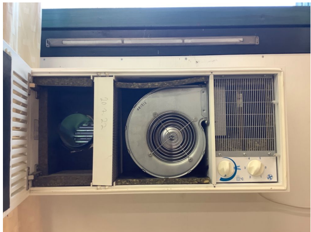
Korvausilmapuhaltimen sisäpuoli. Mobair 2075W. Lämmitystermostaatti on lämmitysasennolla, täysi. puhallinnopeus on 2/5. Ilmansuodatin on vaihdettu 20.7.2022.
