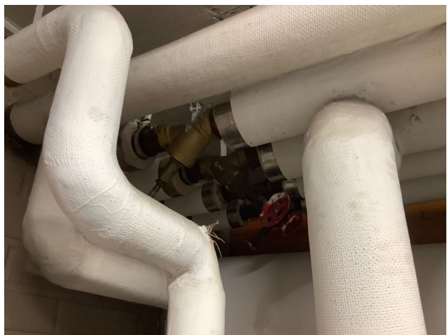
Putkistovarusteissa ei havaittavaa vuotoa.
