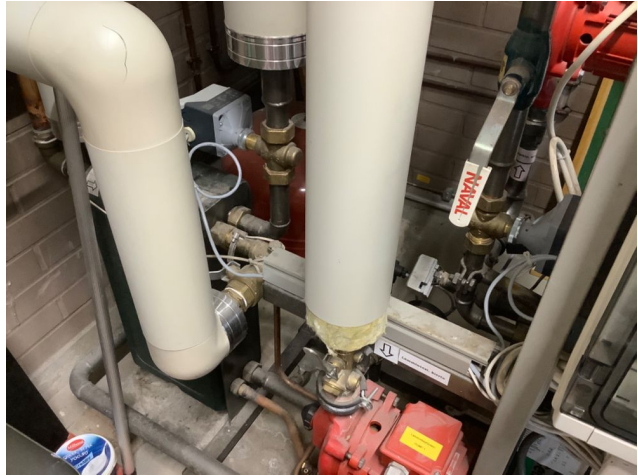
Kaukolämpökeskus on päällisinpuolin hyvässä kunnossa. Vuotoja ei ole havaittavissa. Kaukolämpökeskuksen tekninen käyttöikä on 20...25 vuotta.
