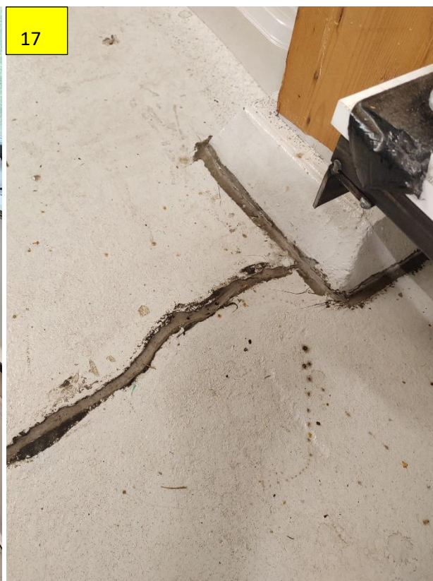
Kuva 16-17. Letkuhuoltokäytävällä havaittiin leveitä halkeamia, joista osaa on paikattu.
