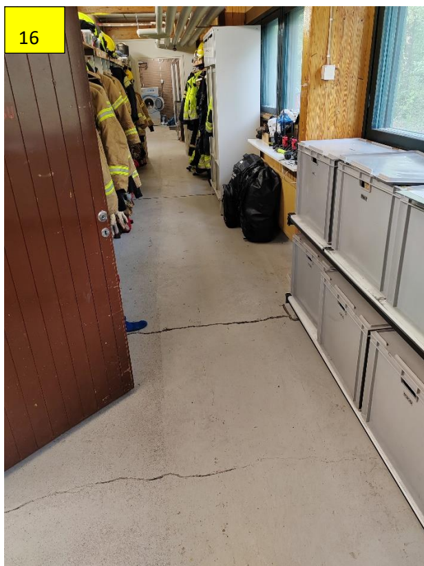
Kuva 16-17. Letkuhuoltokäytävällä havaittiin leveitä halkeamia, joista osaa on paikattu.
