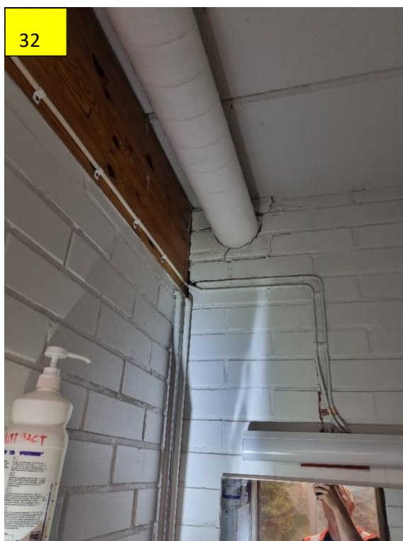
Kuva 32. 1.krs wc-tilan kohdalla tiiliväliseinä ottanut mahdollisesti kantoa.
