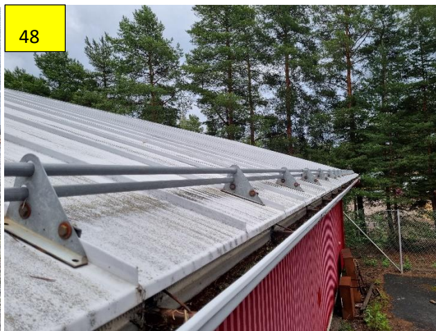
Kuvat 46-48. Kuvia varastorakennuksesta. Ränneissä havuja/lehtiä, ja suositellaan puhdistamaan.
