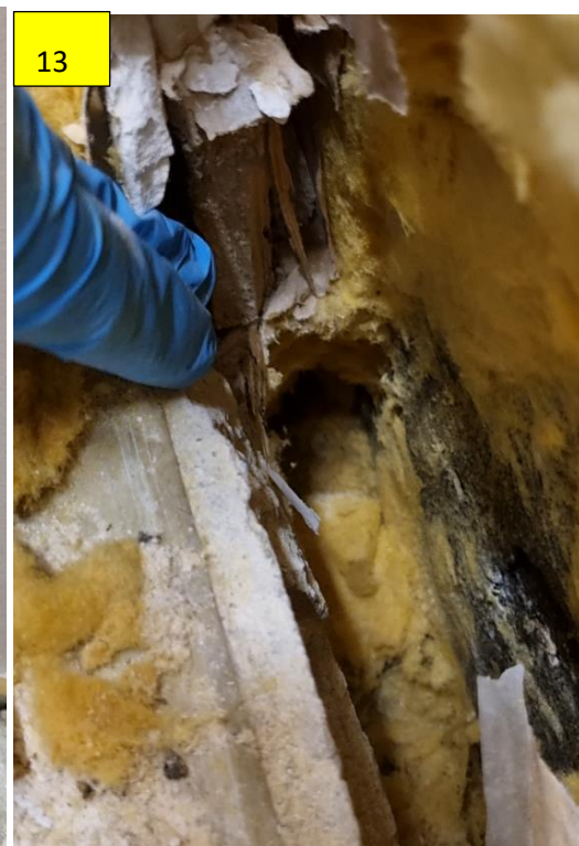
Kuva 12. Alaohjauspuu valesokkelin päällä. Lieviä kosteusviitteitä puuosissa.
