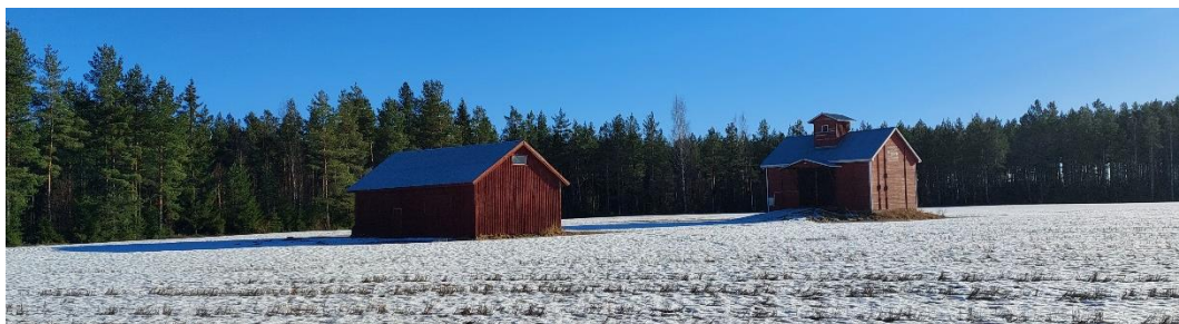
Kuva 3-21. Suunnittelualueella Oikotien varressa sijaitsevia rakennuksia. Vanha asuinrakennus on myöhemmin muutettu viljakuivaamoksi. (Harjavalan kaupunki 2024)
