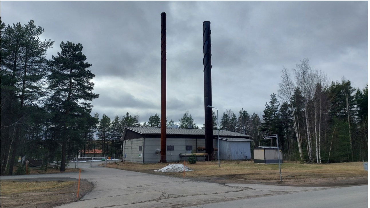
Naapuritontilla sijaitseva Harjavalan Kaukolämpö Oy:n öljykattilarakennus
