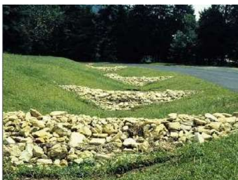
Kuva 4. Esimerkki ojakatkosta (Virginia Stormwater Management Program) tyyppileikkaus huoltoteiden yhteyteen rakennettavista viherpainanteista.
