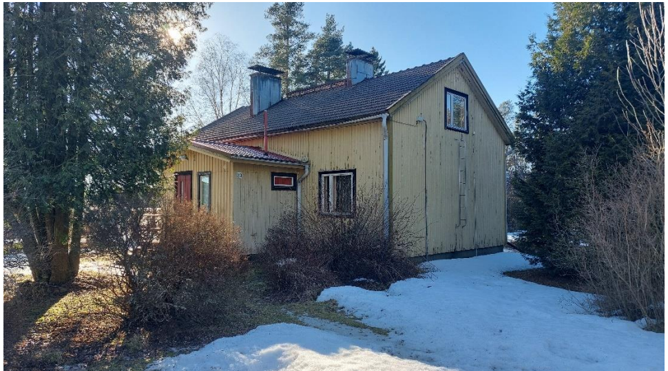
Metsäkulmantie 33, Harjavalta. Rakennusvuosi 1940. (Harjavallan kaupunki 2024)
