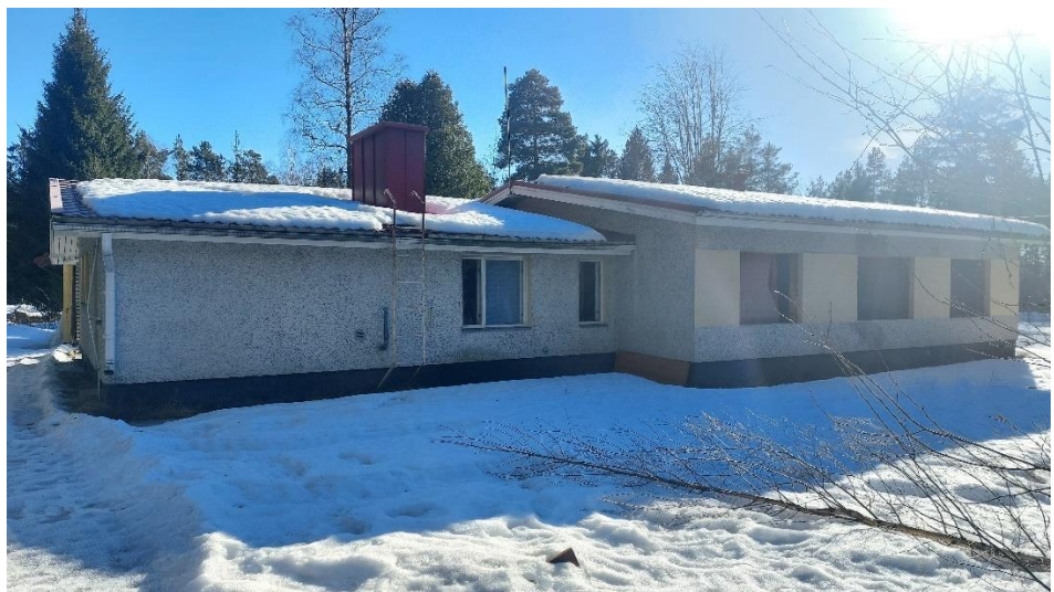
Metsäkulmantie 24, Harjavalta. Rakennusvuosi 1966. (Harjavallan kaupunki 2024)
