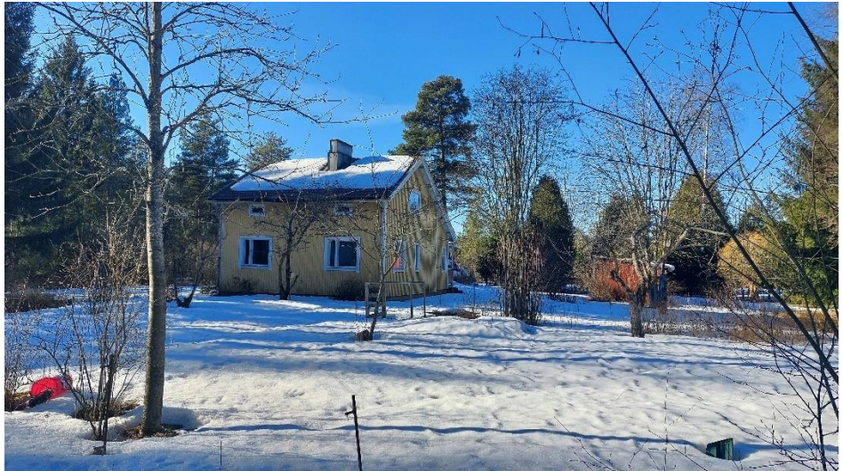
Metsäkulmantie 26, Harjavalta. Rakennusvuosi 1952. (Harjavallan kaupunki 2024)
