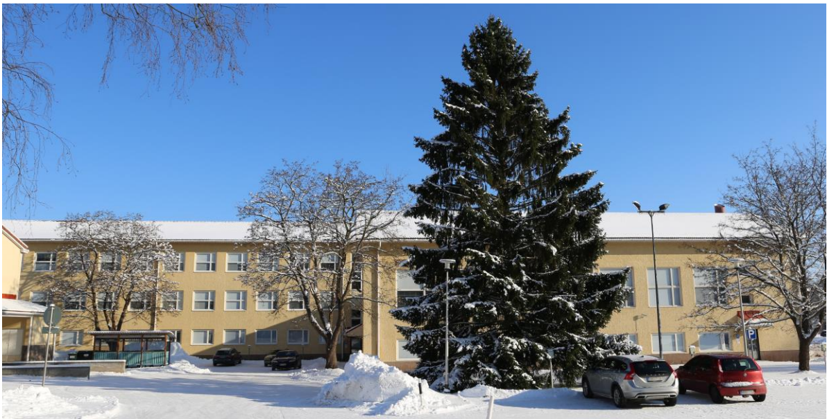
Kuva 3-20. Yläkoulun länsijulkisivu Myllykadun suuntaan. Vasemmalla luokkasiipi ja oikealla voimistelusalisiipi. (Ramboll 2023)
