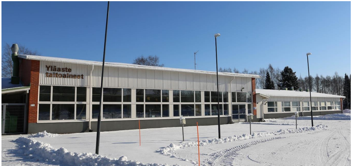
Kuva 3-21. Entisen lukion länsijulkisivu Myllykadun suuntaan. (Ramboll 2023)
