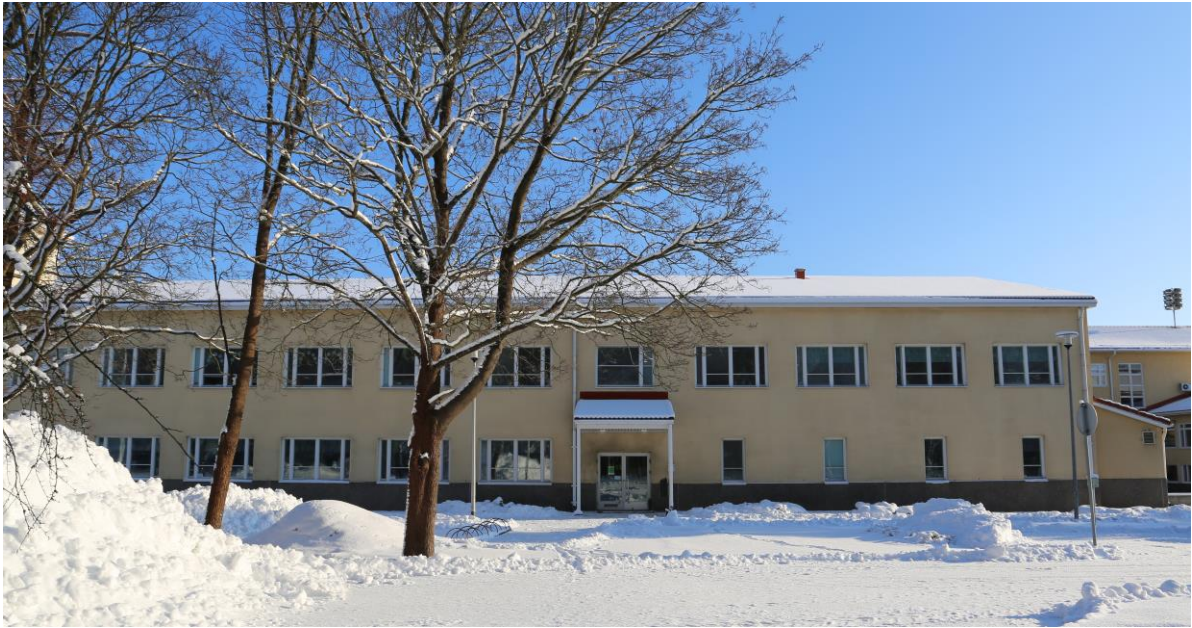
Kuva 3-19. Alakoulun laajennusosan länsijulkisivu Myllykadun suuntaan. (Ramboll 2023)
