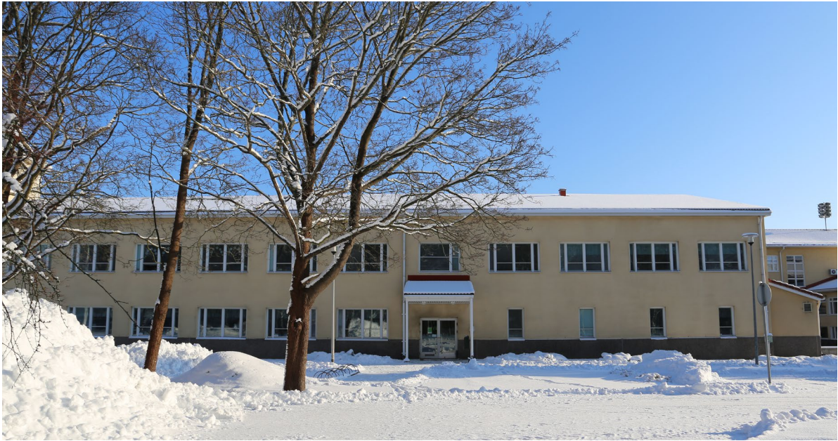
Kuva 3-19. Alakoulun laajennusosan länsijulkisivu Myllykadun suuntaan. (Ramboll 2023)
