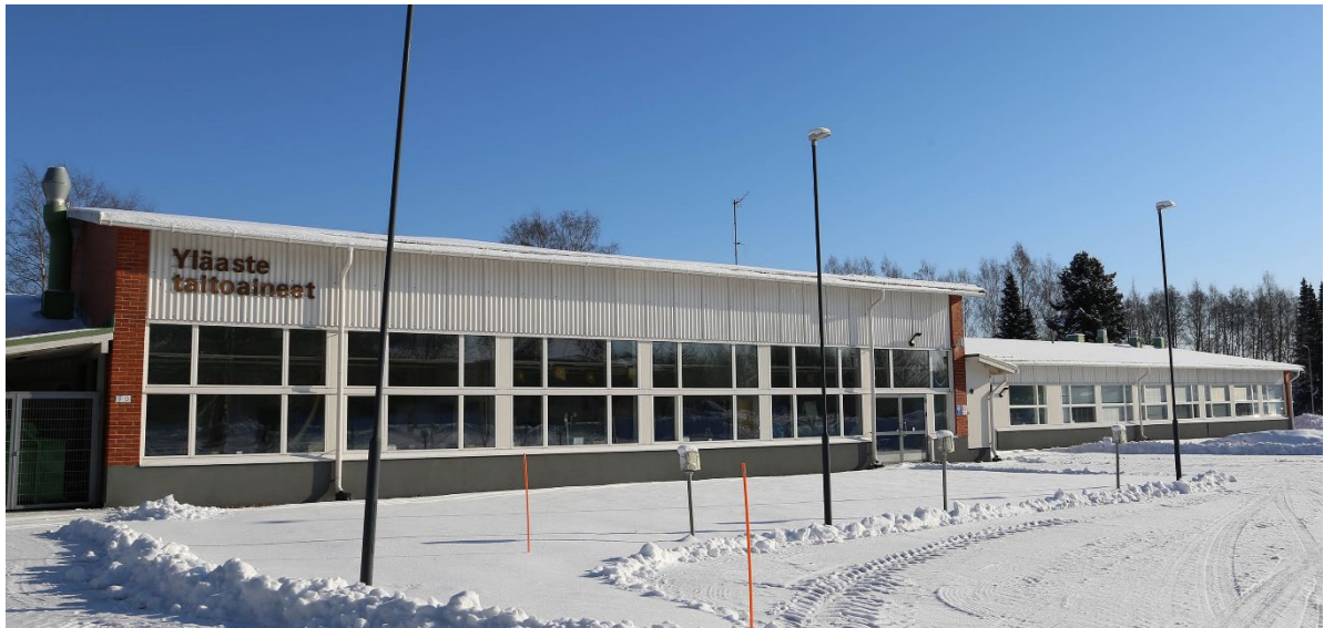
Kuva 3-21. Entisen lukion länsijulkisivu Myllykadun suuntaan. (Ramboll 2023)
