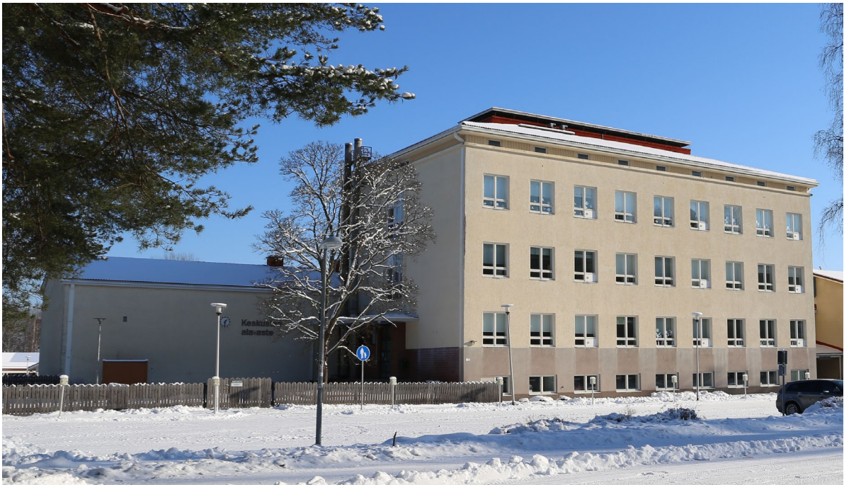
Kuva 3-16. Alakoulun länsijulkisivu Myllykadulle päin. Vasemmalla kaksikerroksinen voimistelusalisiipi ja oikealla nelikerroksinen luokkasiipi. Koulun kattomuoto ja julkisivut ovat säilyneet alkuperäisinä. (Ramboll 2023)
