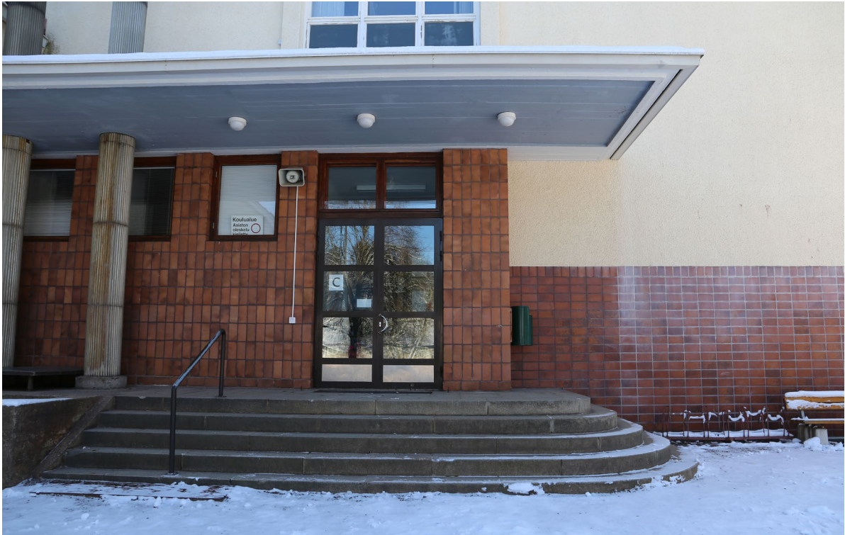
Kuva 3-17. Alakoulun pohjoisjulkisivun pääsisäänkäynti on säilynyt pitkälti alkuperäisenä ovea lukuun ottamatta. (Ramboll 2023)
